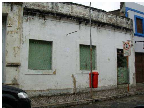
Figura 9. Localización e identificación de las reminiscencias arquitectónicas.
