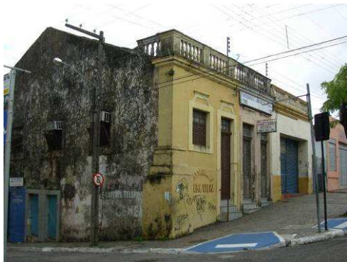
Figura 8. Localización e identificación de las reminiscencias arquitectónicas.
