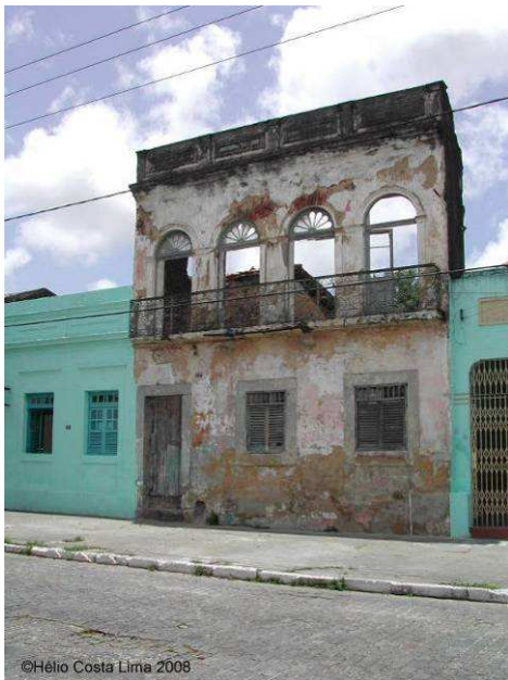
Figura 4. Aspecto actual de trecho de la Calle General Osório (antigua Calle Nova).
