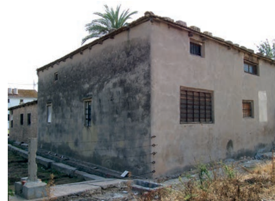
1. Diferentes tipos de imágenes manejadas en las labores de documentación de un edificio: a. Visible (en color); b. Infrarrojo térmico (en falso color)
