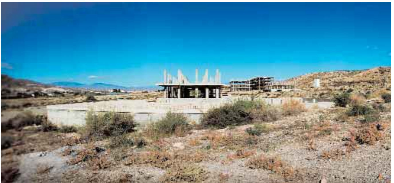
Estructuras visibles 05. Viator, Almería.
