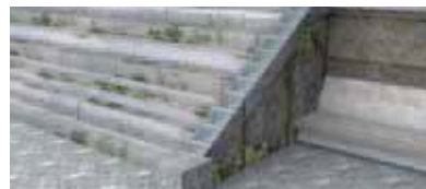
Fig.17: Animación de la escalera que da acceso a la galería de la fachada posterior, se observan los bloques de granito. Fuente: PFG.RLJ
