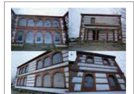
Fig. 5: Detalle de las diferentes fachadas, donde se puede apreciar el ladrillo rojo, empleado como principal elemento decorativo. Fuente: PFG.RLJ.
